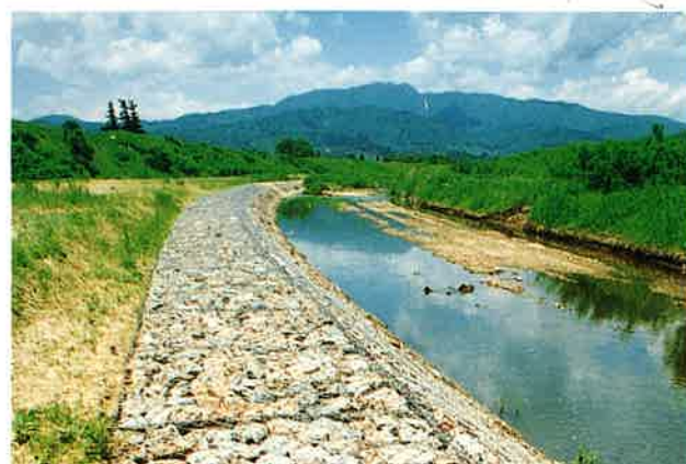
山形県村山建設事務所 白水川左岸護岸復旧
