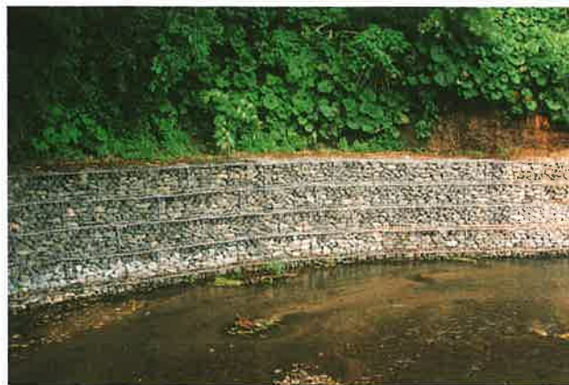
青森県十和田土木事務所 大林川改修
