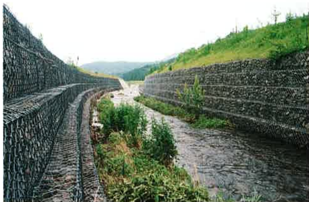
宮城県名取市役所 大沢川災害関連工事
