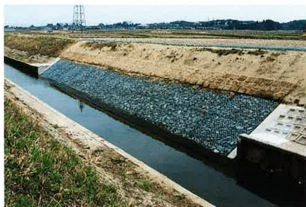
福島県相双建設事務所 河川災害復旧工事（飯崎川）
