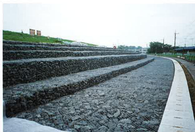
国土交通省関東地方整備局利根川上流河川事務所 栗橋堤防強化対策工事
