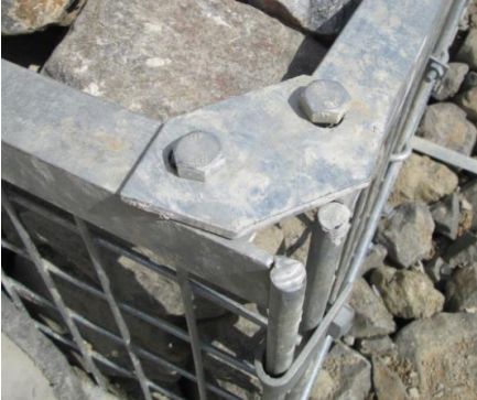
C: 角継ぎプレート取付部
