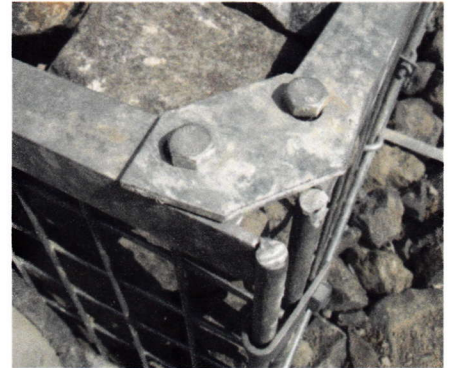
C: 角継ぎプレート取付部
